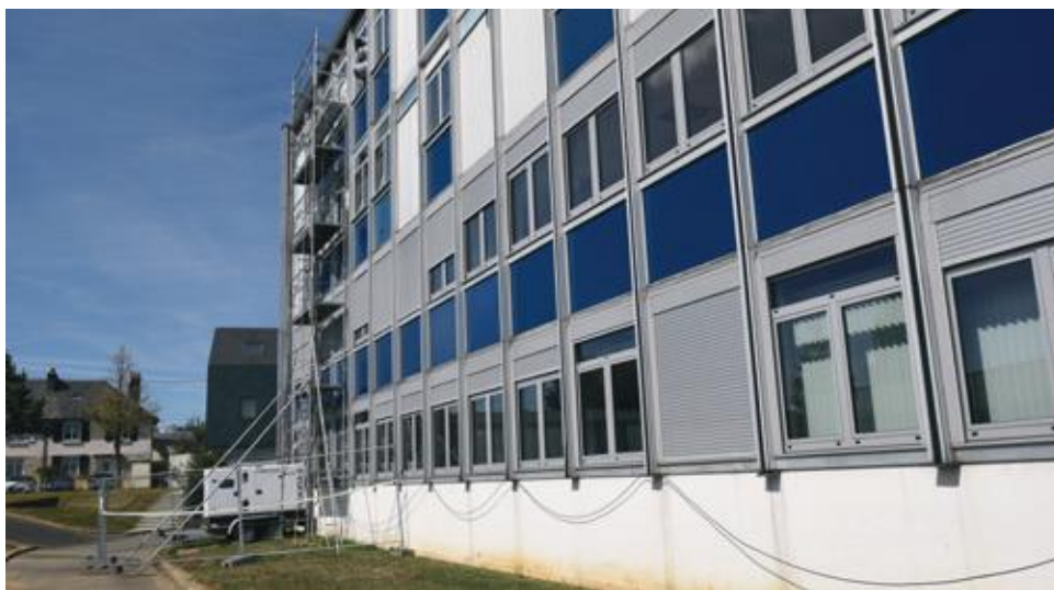
➤ Réalisation des travaux dans les lycées © Région Normandie
