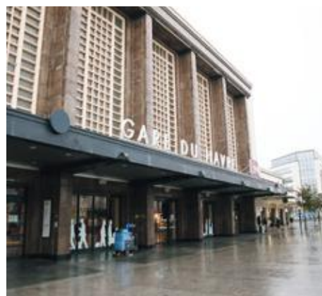
➤ Travaux de mise en accessibilité à la gare du Havre © Région Normandie
