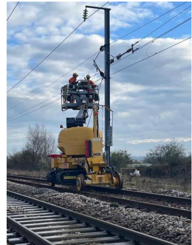
Les équipes SNCF Réseau en train de déposer la caténaire, le 14/01, pour permettre à la grue Kirow de manœuvrer.
